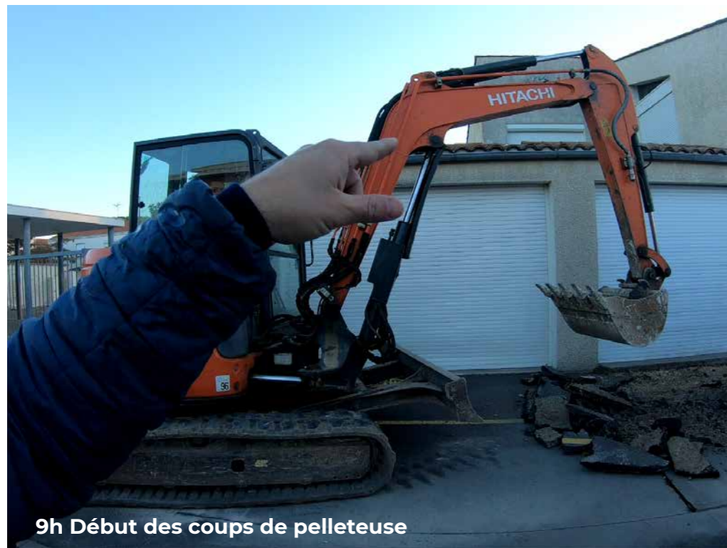
Décroûtage de la surface de l'enrobé
