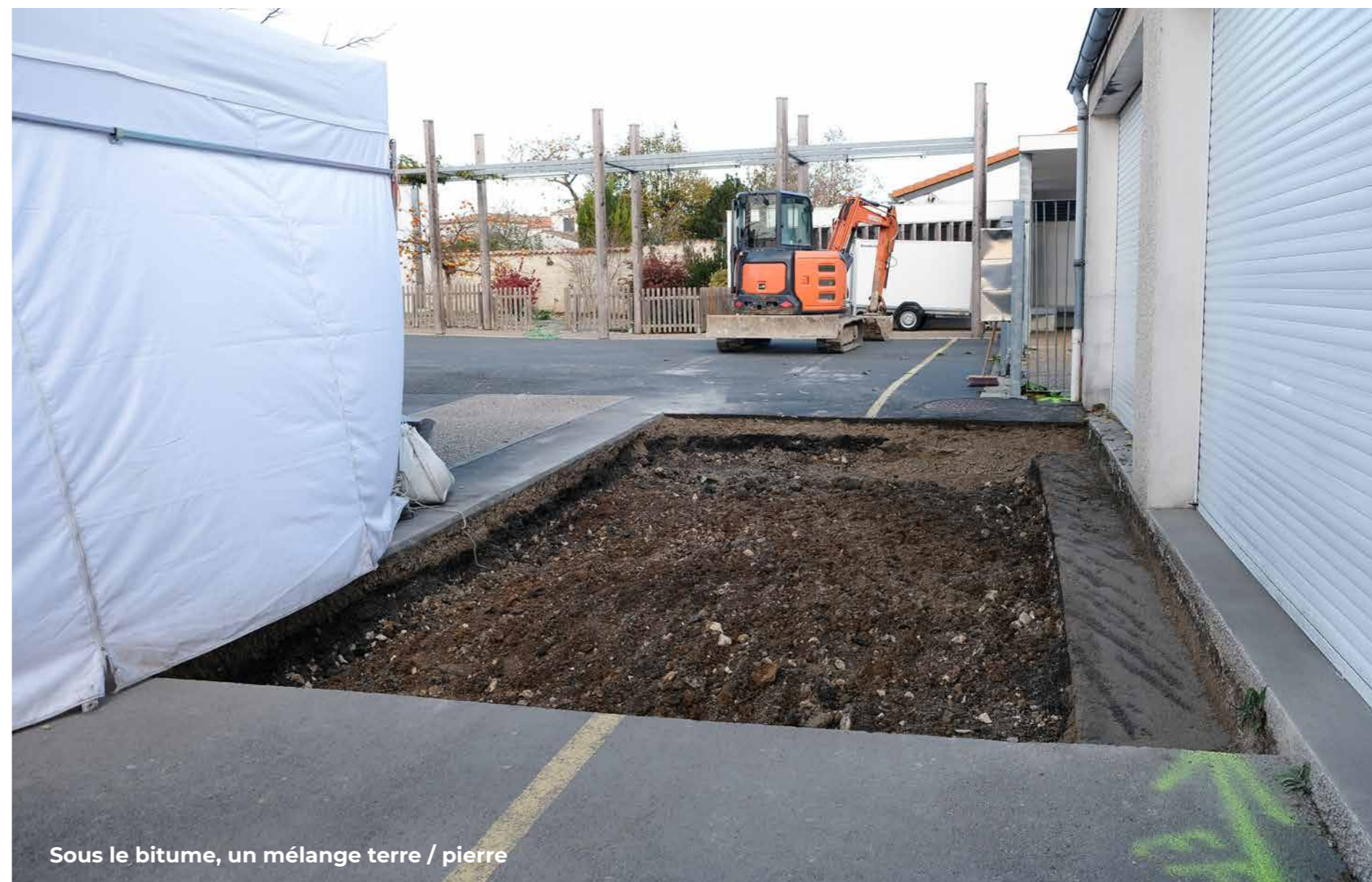
Décroûtage de la surface de l'enrobé
