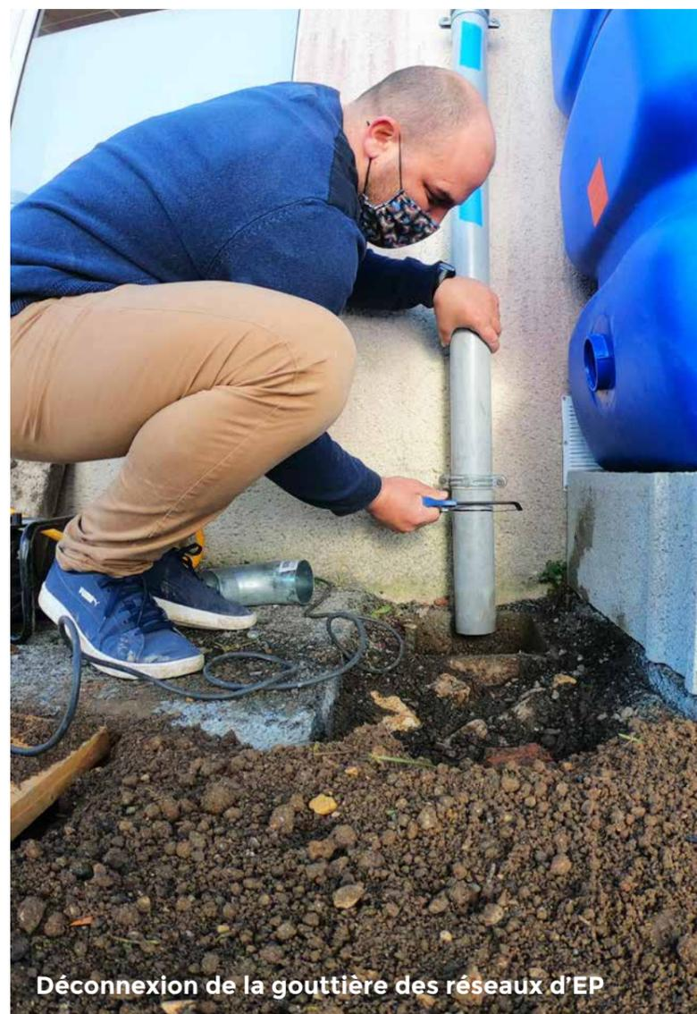
Déconnexion de la gouttière des réseaux d'EP
