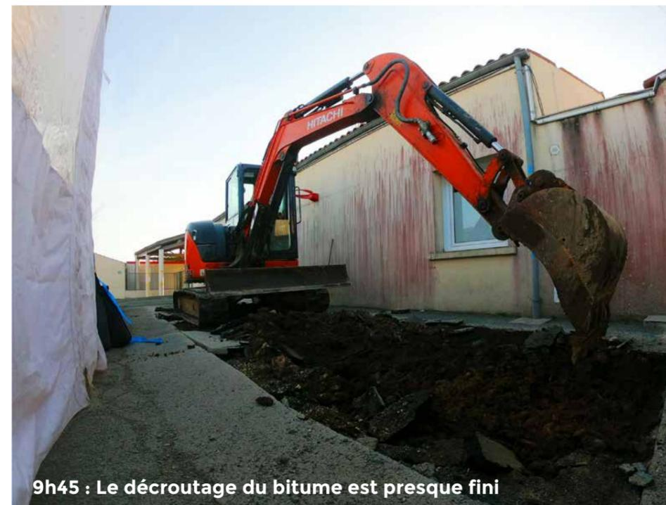
9h45 : Le décaissage du bitume est presque fini
