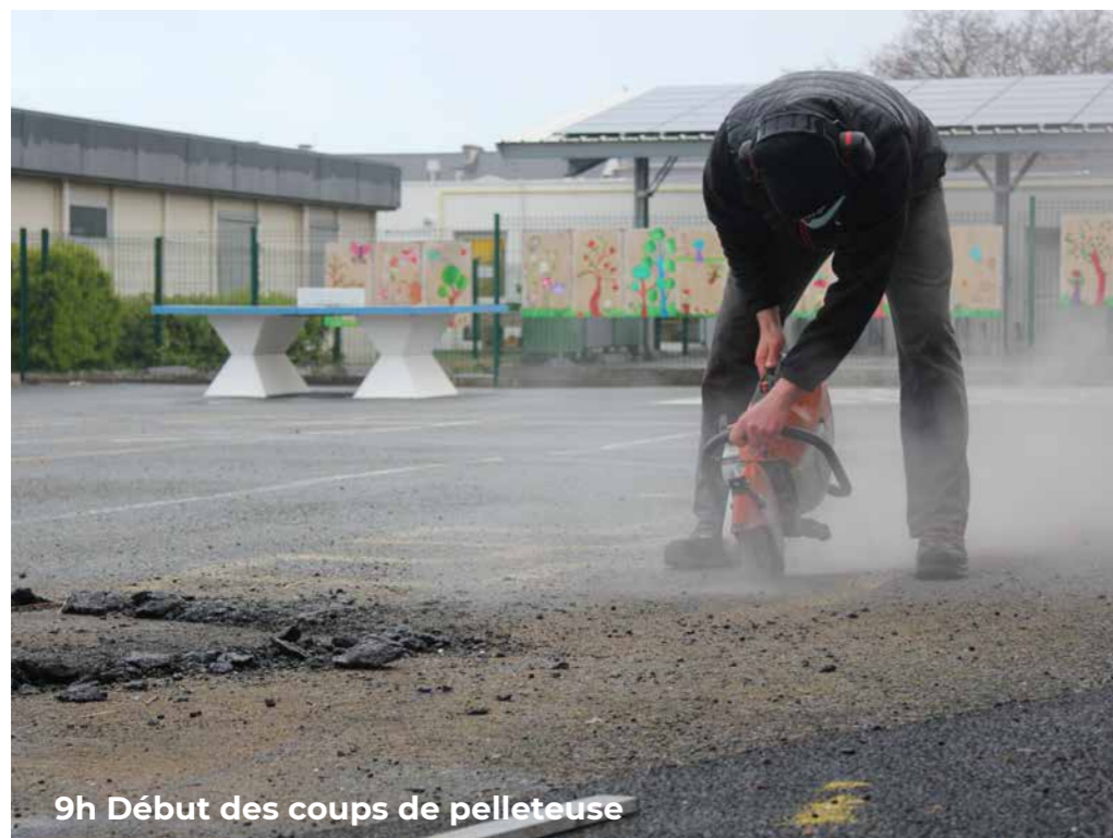
Décroûtage de la surface de l'enrobé
