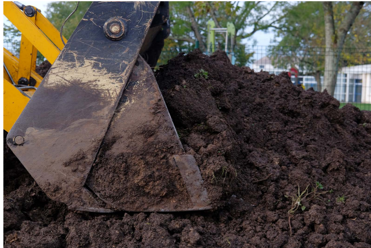
Travaux le mercredi (jour sans enfant) - dépose de l'enrobé
