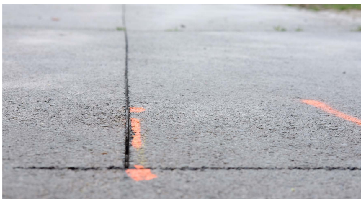
Sciage de l'enrobé pour préparer les travaux
