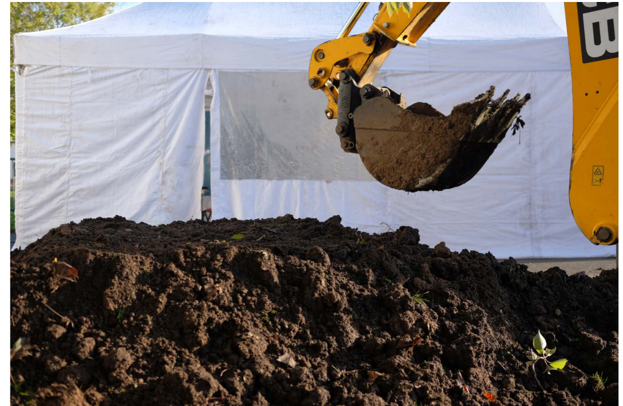
Apport de terre végétale
