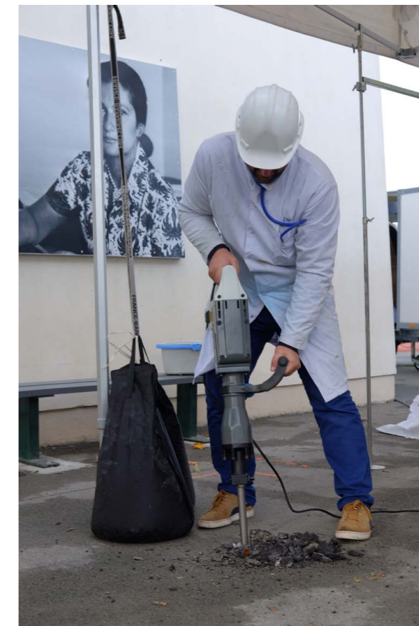
Morceaux d'enrobés retirés au marteau piqueur pour installer la tête du géant
